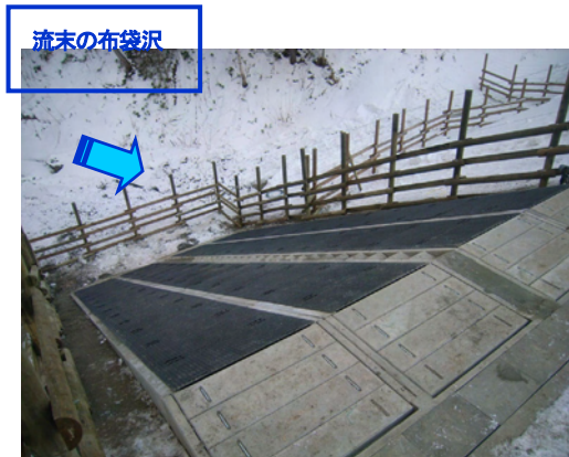
図-5 中和水路構造物（上方から撮影）
