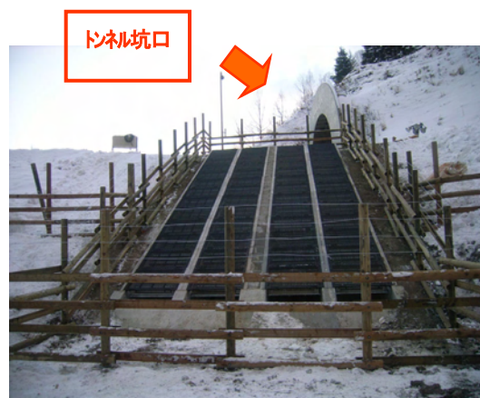
図-4 中和水路構造物 (下方から撮影)
