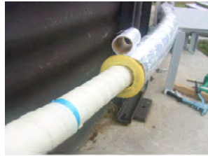
写真-7 ヒーター巻付状況 写真-8 保温材巻付状況
