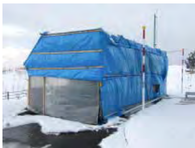
写真-9 防寒囲い状況
