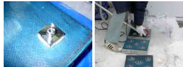
アタッチメント取り付け 切り込み施工 写真-10 アタッチメント取り付け状況
