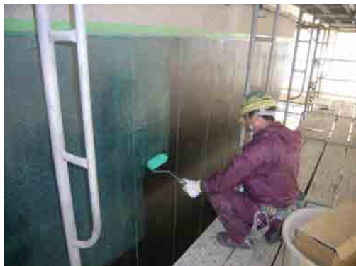
写真-1 高強度繊維補強工法の冬期施工状況
