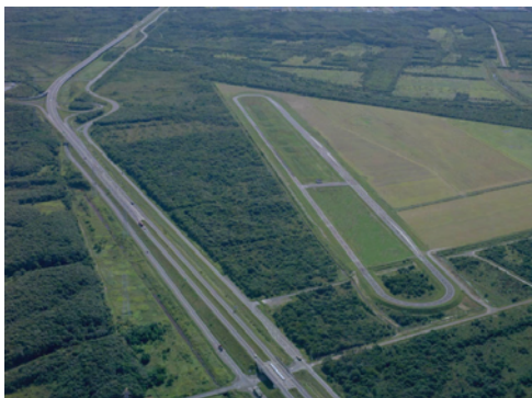
写真-2 苫小牧寒地試験道路全景
