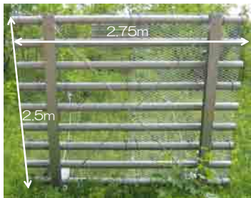
写真 2 エクスパンドパネルを取り付けた雪崩柵
