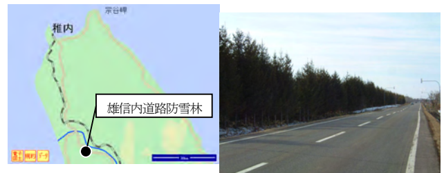
図-0 現地観測箇所
