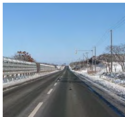
写－３ 防雪柵開口部
