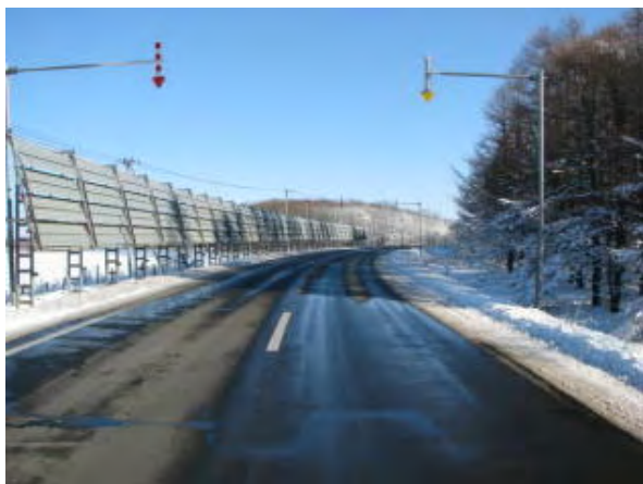
写－２ 吹き払い柵
