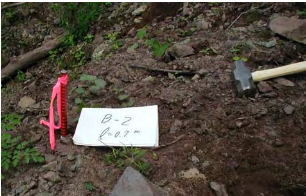
写真-1 鉄筋杭設置状況 (崩-1 B2)
