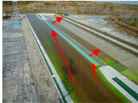
2. 越流堤に流入している様子
