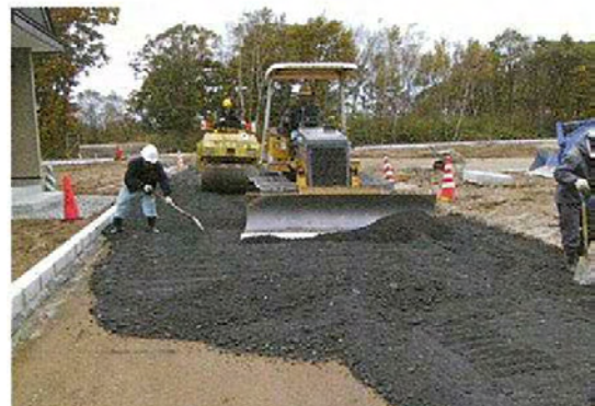
写真-2 路盤材への利用例 (石炭灰造粒物)
