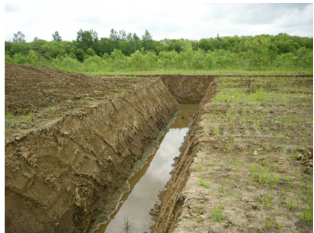
写真-1 トレンチ排水工
