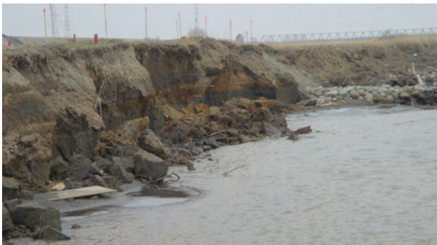
写真-1 河岸浸食の状況 平成20年4月16日撮影
