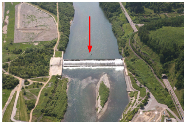
写真-1 千代田堰堤の外観
