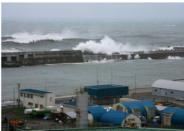
図1-1 網走港 南防波堤越波状況 (2006.10.8)
