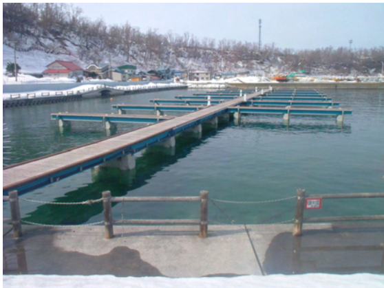
写真-6 完成状況
