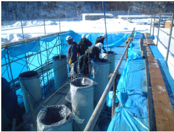
写真-4 中詰コンクリート打設
