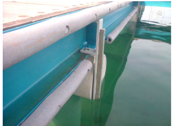
写真-7 防舷材設置状況
