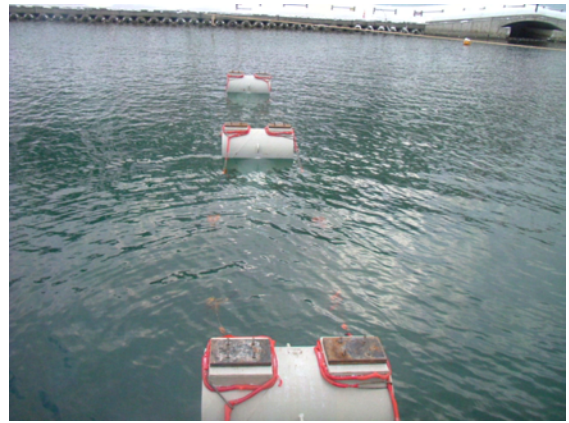
写真-5 枕梁仮置状況
