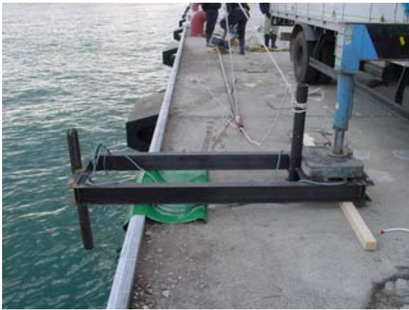
写真-2 動揺保持用固定架台写真
