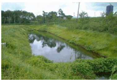
写真-2 排水調整池 (写真は先行地区の事例)
