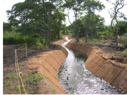
写真-1 河道整備箇所（施工直後）
