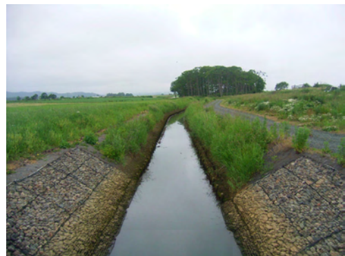
写真-2 自然繊維シートによる植生回復状況(施工後2年目)
