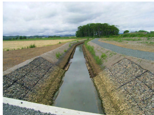
写真-1 自然繊維シートによる植生回復状況(施工後1年目)
