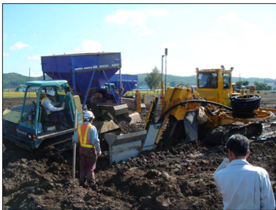
図-3 高速自動暗渠管理設機による施工
