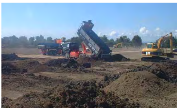
写真-5 中樹林地区における客土工事風景
