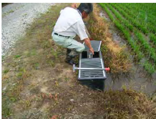
写真-1 ユニットでの水位調整作業風景
