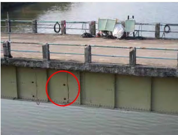
写真-4 ひずみゲージ設置状況
