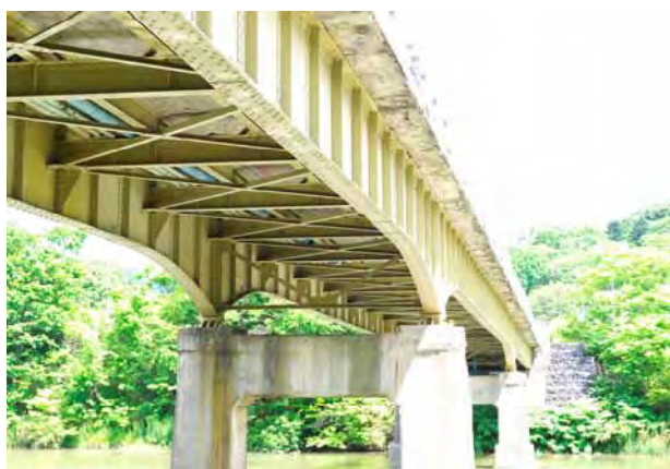
写真-2 旭橋の上部工の状況
