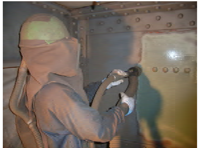
バキュームブラスト施工状況
