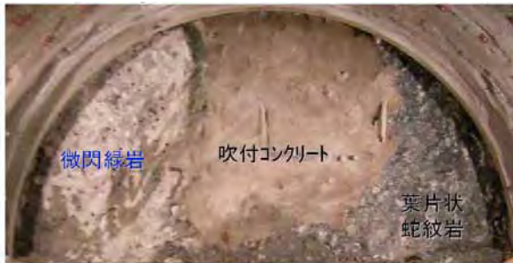
写-2 微閃緑岩出現状況写真 (P=138, 600 起点坑口から約 550m 付近)
