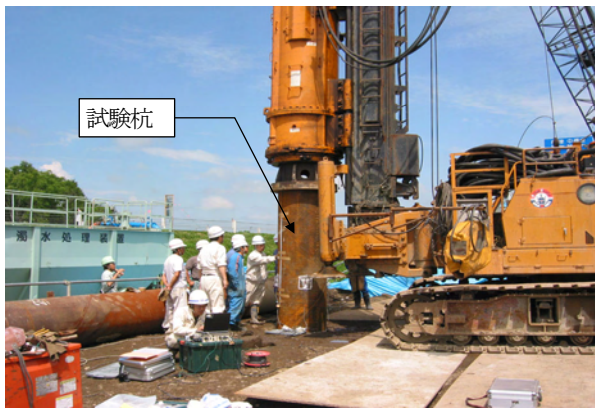
写真-2 SPP 衝撃载荷試験状況
