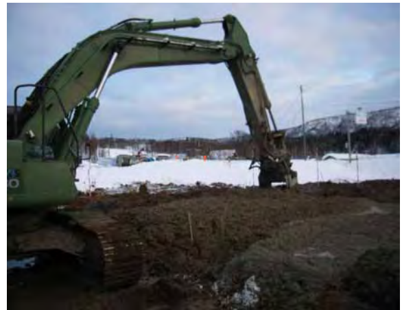
写真-2 厳冬の施工状況
