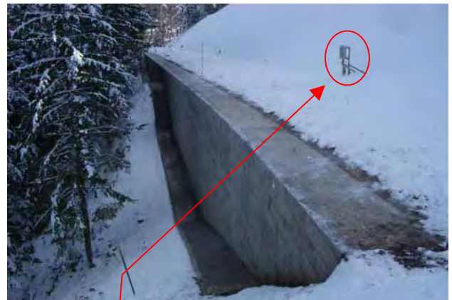
写真-8 温度計設置箇所およびデータロガー
