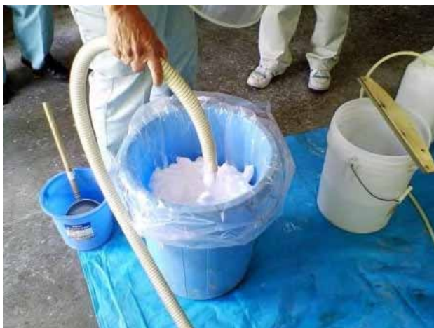
写真-2 起泡材発泡状況
