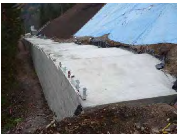
写真-7 (完成写真) 終点より
