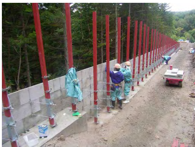
写真-4 コンポジット取付状況
