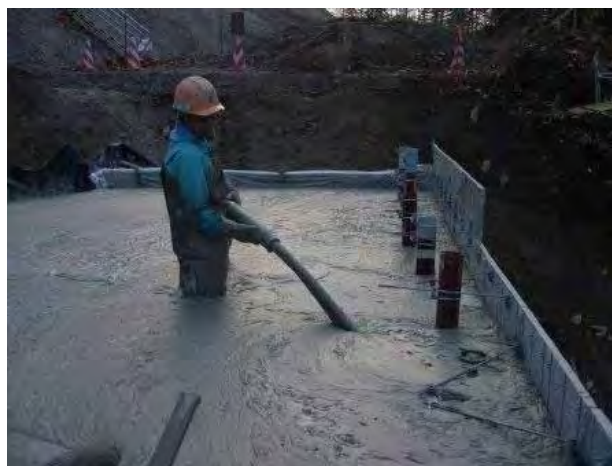
写真-6 打設状況
