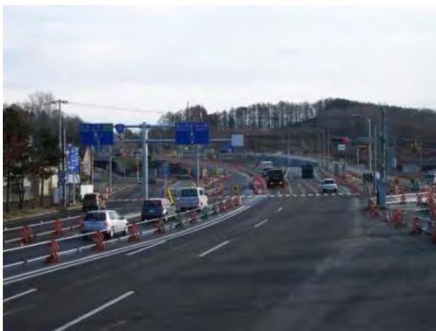
写真-3 全線4車線供用した直後 (台場地区：札幌方面から旭川方面を撮影)
