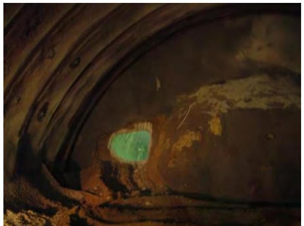
写真-2 貫通状況 終点側から起点側(札幌方面)を撮影
