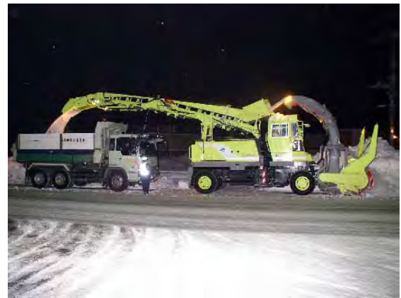
写真-2 運搬除雪作業状況（縦列）
