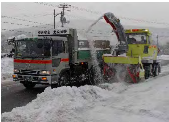
写真-1 運搬除雪作業状況（並列）
