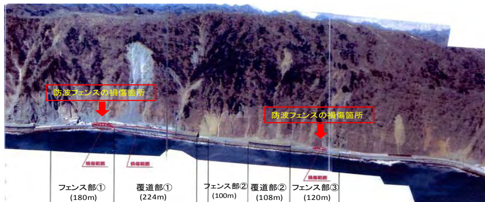
写真-1 被災場所におけるフェンスの損傷箇所
