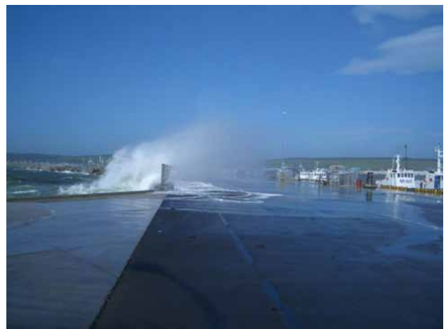
写真-1 飛沫状況写真(平成17年9月8日撮影)
