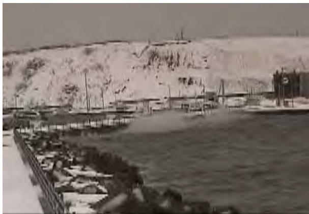
写真-2 護岸越波状況(平成 19年 2月 15日)
