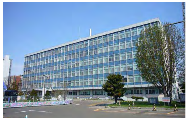
図-1.1 札幌開発総合庁舎全景
