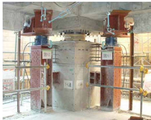
図-6.1 免震装置設置完了
