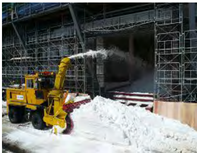
写真-2 ロータリー除雪車による雪の投入
