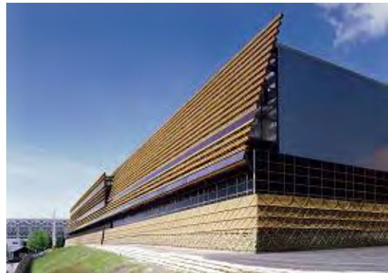
写真-1 IMC建物外観
