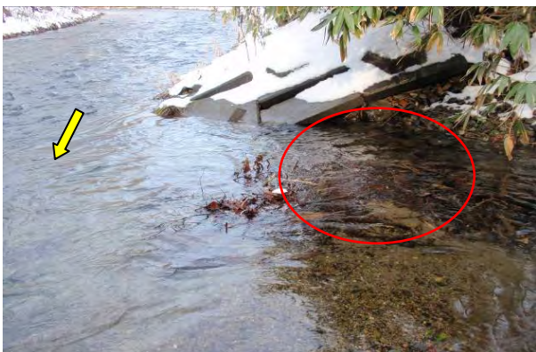
写真-5 下流越冬場所 (SP150左岸、護岸工下流端部)
