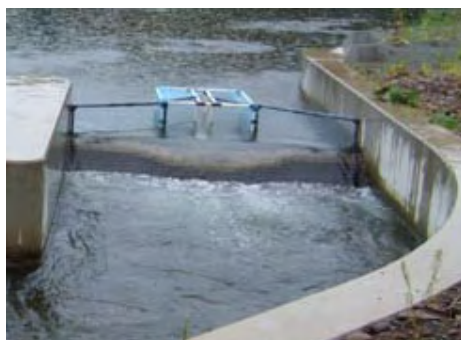
写真-2 トラップ設置状況
