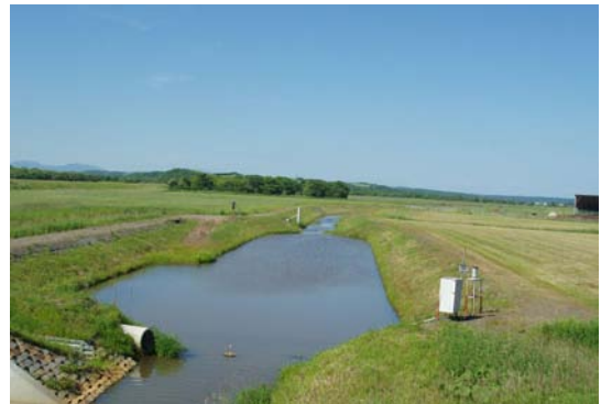
写真1 シロンド排水路沈砂池
