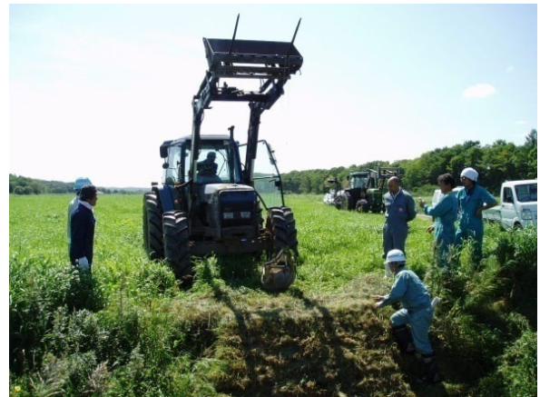
写真3 沈砂柵堆積土砂除去状況
