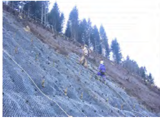
写真7 植生基材吹付工の施工状況
