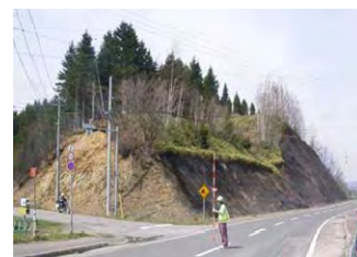
写真1 着工前ののり面
