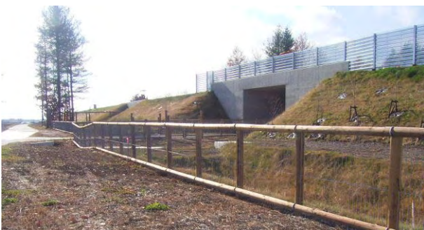
写真1-1. 帯広型立入防止柵設置状況
