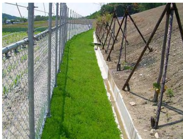
図-8 法尻のハーブマットと移植した半成木
