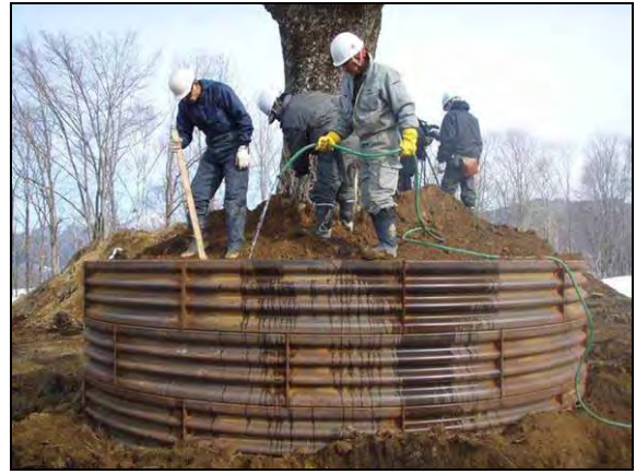
写真 4 砂の充填・水の注入 (平成 20 年 1 月 23 日撮影)
