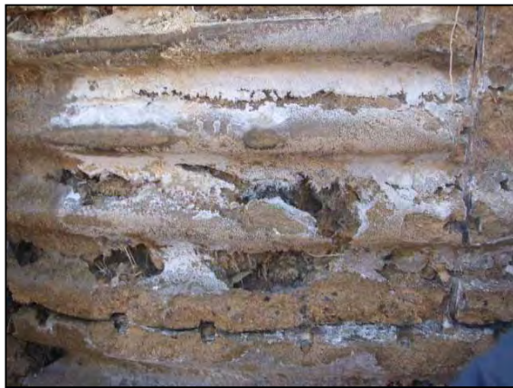
写真7 ライナープレート取り外し直後 (平成20年2月9日撮影)
