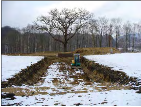
写真 2 掘削後のカシワの根鉢と運搬路 (平成 20 年 1 月 16 日撮影)
