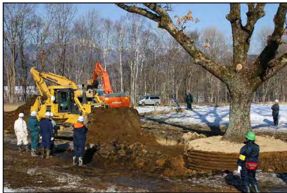
写真8 埋め戻し作業(平成20年2月9日撮影)
