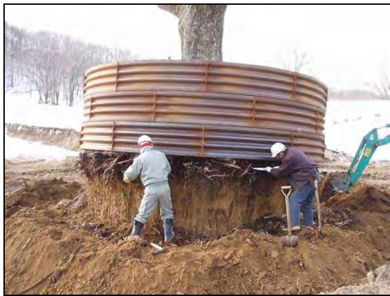
写真 3 ライナープレートの設置 (平成 20 年 1 月 23 日撮影)
