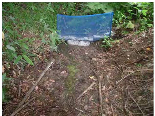
写真-5 工事箇所への移動防止用ネットの設置状況
