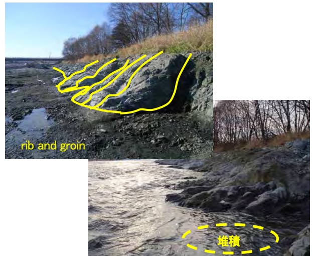
図-14 河岸掘削前後
