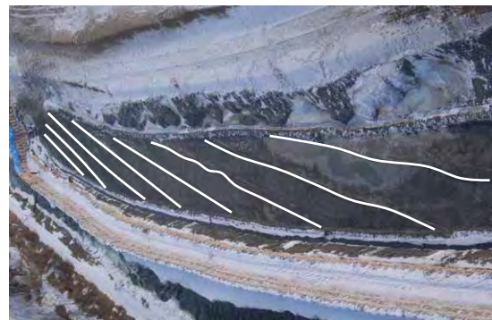
図-15 コンターライン掘削
