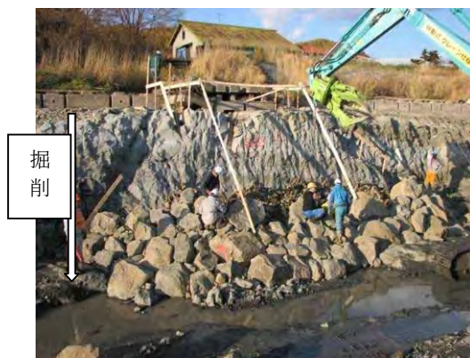
図-11 最下流水制工
