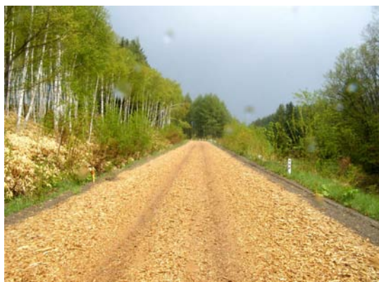
図8 チップ材敷設状況
