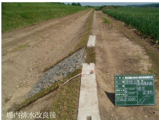
図11 堤内排水の改良状況
