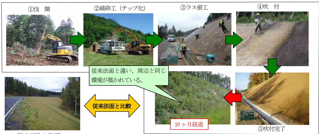
写真-4 植物誘導吹付工の流れ
