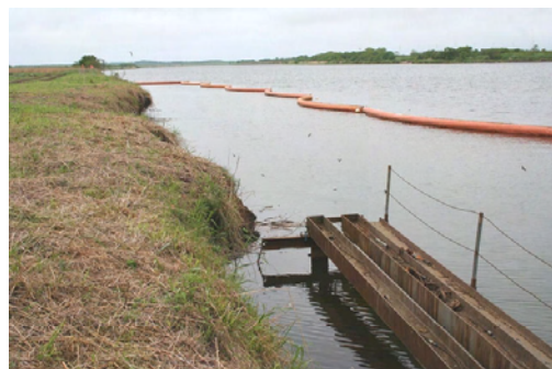
写真-5 矢板振止定規
