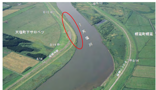
写真-1 工事箇所 (KP13.4～13.8)
