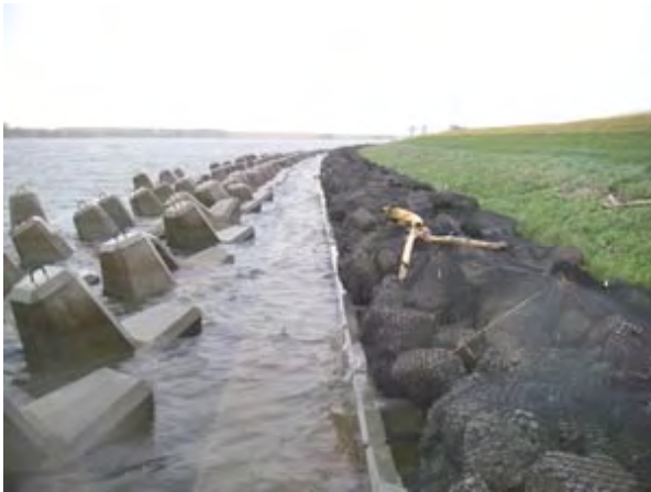
写真－2 完成した護岸
