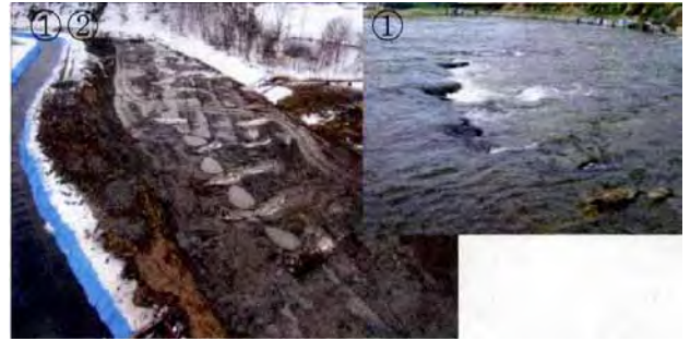
写真-1 6 分散型落差工①・等高線掘削②
