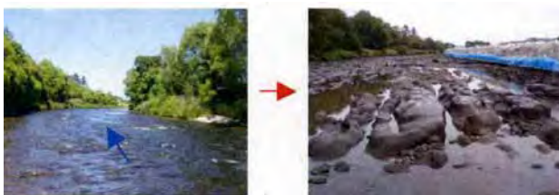
写真－9 仮締切時に確認した河床の露岩状況
