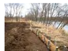
写真-7 土砂流出防止対策
