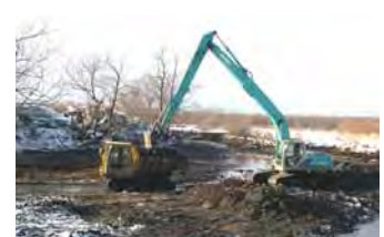
写真-4 旧川掘削状況
