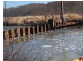
写真-3 矢板打込み状況
