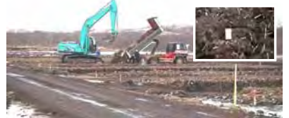
写真-8 ヨシ表土の運搬・敷均し状況
