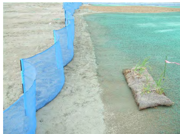
写真-13 植生土のう設置状況(H18年設置)
