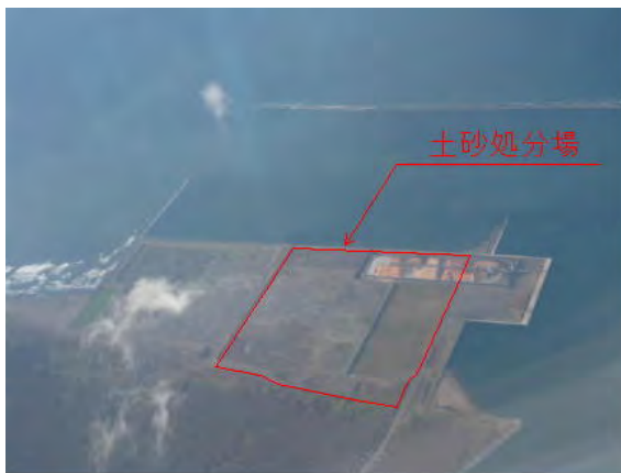
写真-1 石狩湾新港西地区土砂処分場
