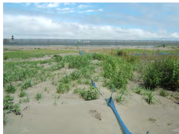
写真-14 植生土のう植生回復状況(H20年8月状況)
