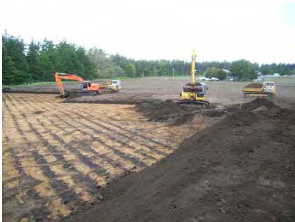
写真-4 表土はぎ作業状況(5月下旬)
