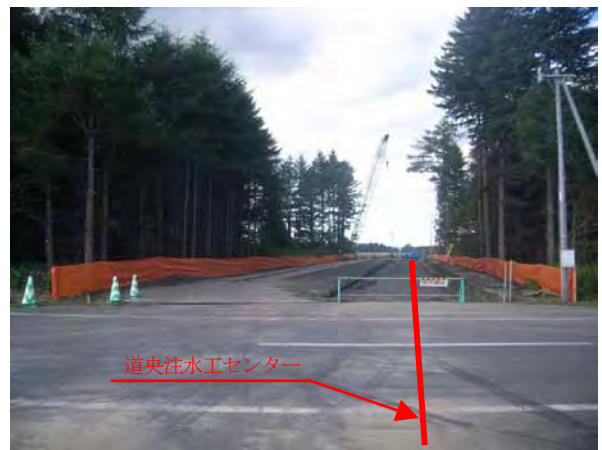
写真-7 防風林横断施工後状況
