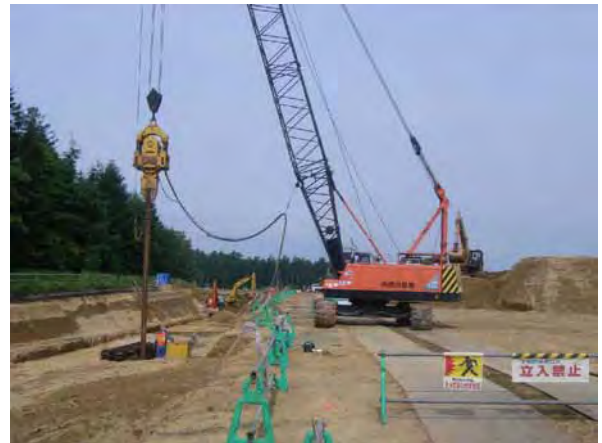
写真-5 鋼矢板打ち込み状況(7月上旬)
