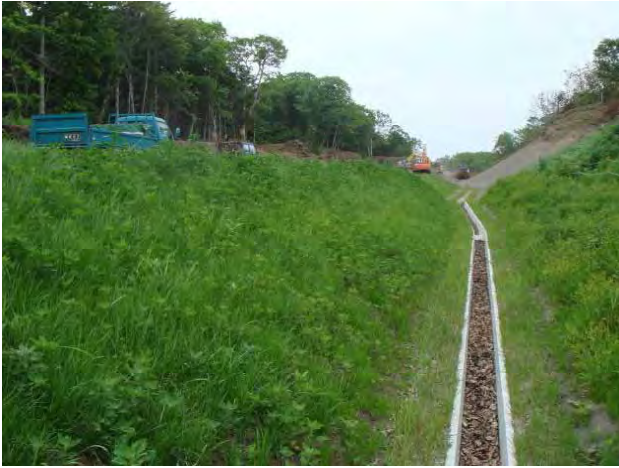
②6月中旬撮影 写真-4 泥炭+種子散布被植状況
