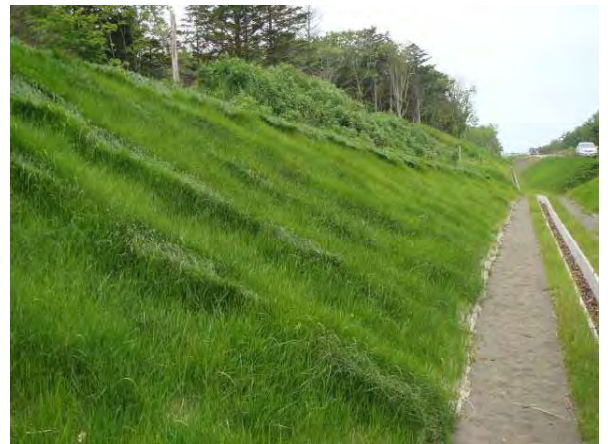
②6月中旬撮影 写真-6 恒性微生物菌緑化工法被植状況
