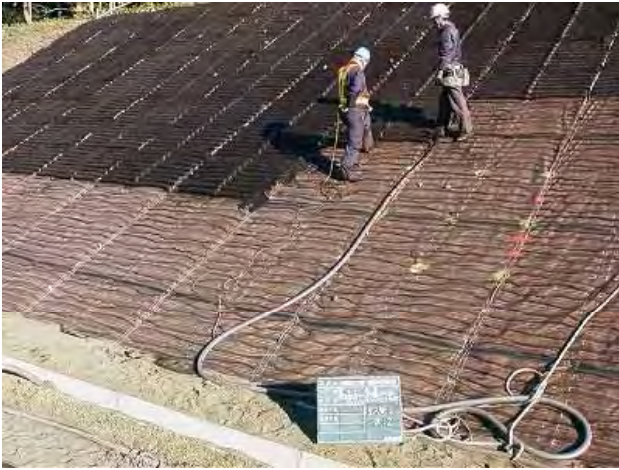
写真-2 バイオ植生注入マット施工状況
