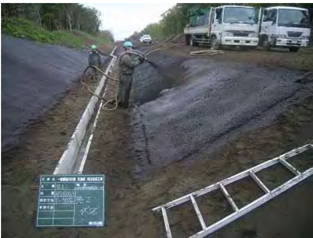
写真-3 恒性微生物菌施工状況
