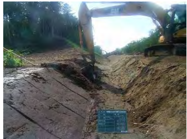
写真-1 泥炭の張付状況
