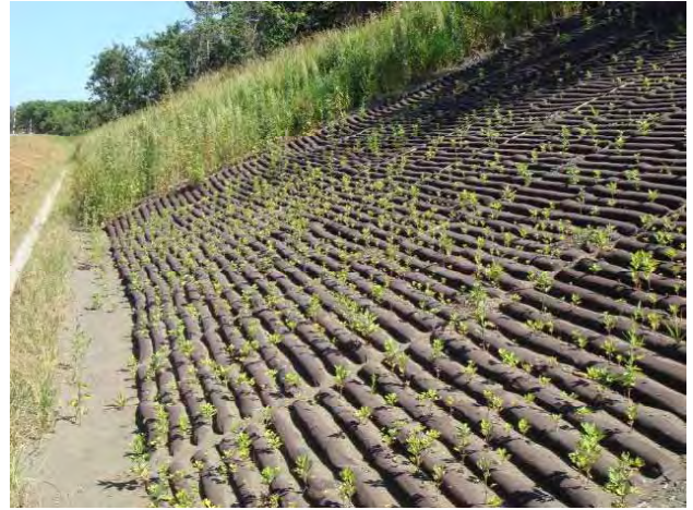
②8月下旬撮影 写真-5 バイオ植生注入マット工法被植状況
