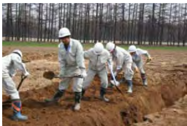
写真-4 農業土木工学科3年表土埋戻し
